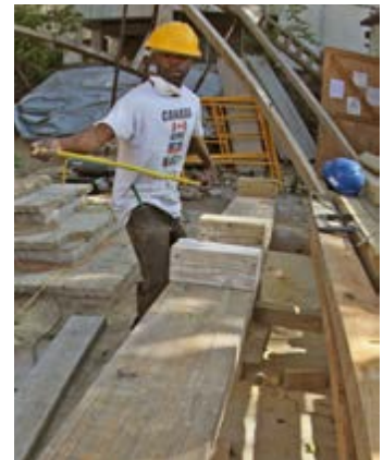
Délicat assembles shoring elements.
